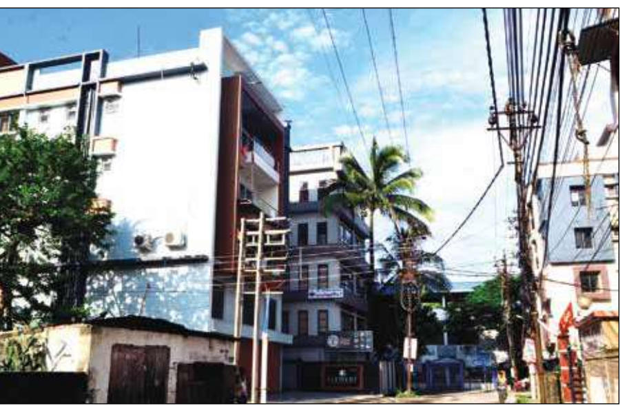
সেবক রোড সংলগ্ন রামকৃষ্ণ-বিবেকানন্দ রোডের বহুতল। ছবি : সঞ্জীব সূত্রধর
