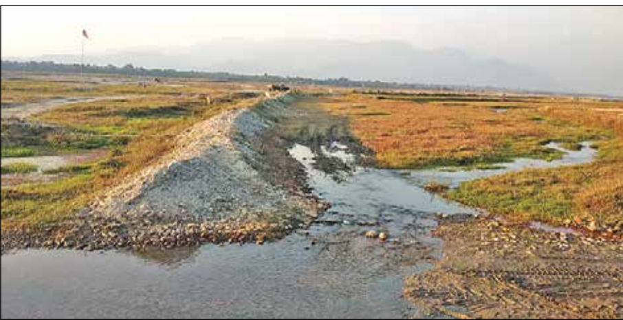
মেচি নদীর বড় মণিগ্রামজোতে আটকে বাঁধ নির্মাণের কাজ। - সংবাদচিত্র
