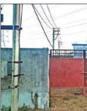
কুমারটোল এলাকায় বন্ধ হয়ে থাকা জলপ্রকল্পের কাজ।
