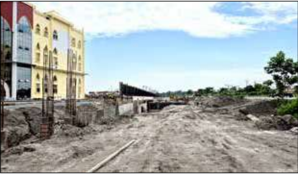
পাহাড়পুরে হাইকোর্টের জলপাইগুড়ি সার্কিট বেঞ্চের স্থায়ী ভবনের সামনে সার্ভিস রোড তৈরির কাজ চলছে জোরকদমে।
