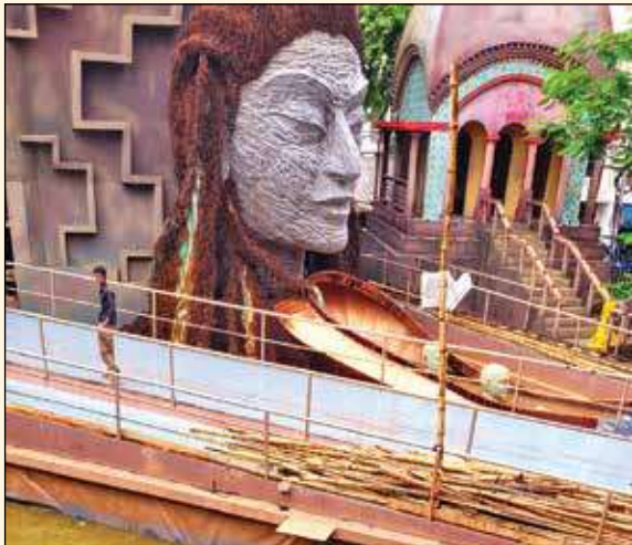
মদনমোহনবাড়ির মণ্ডপসজ্জার কাজ চলছে।
